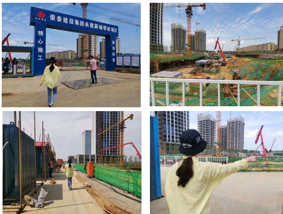
图 3.1 现场踏勘照片
