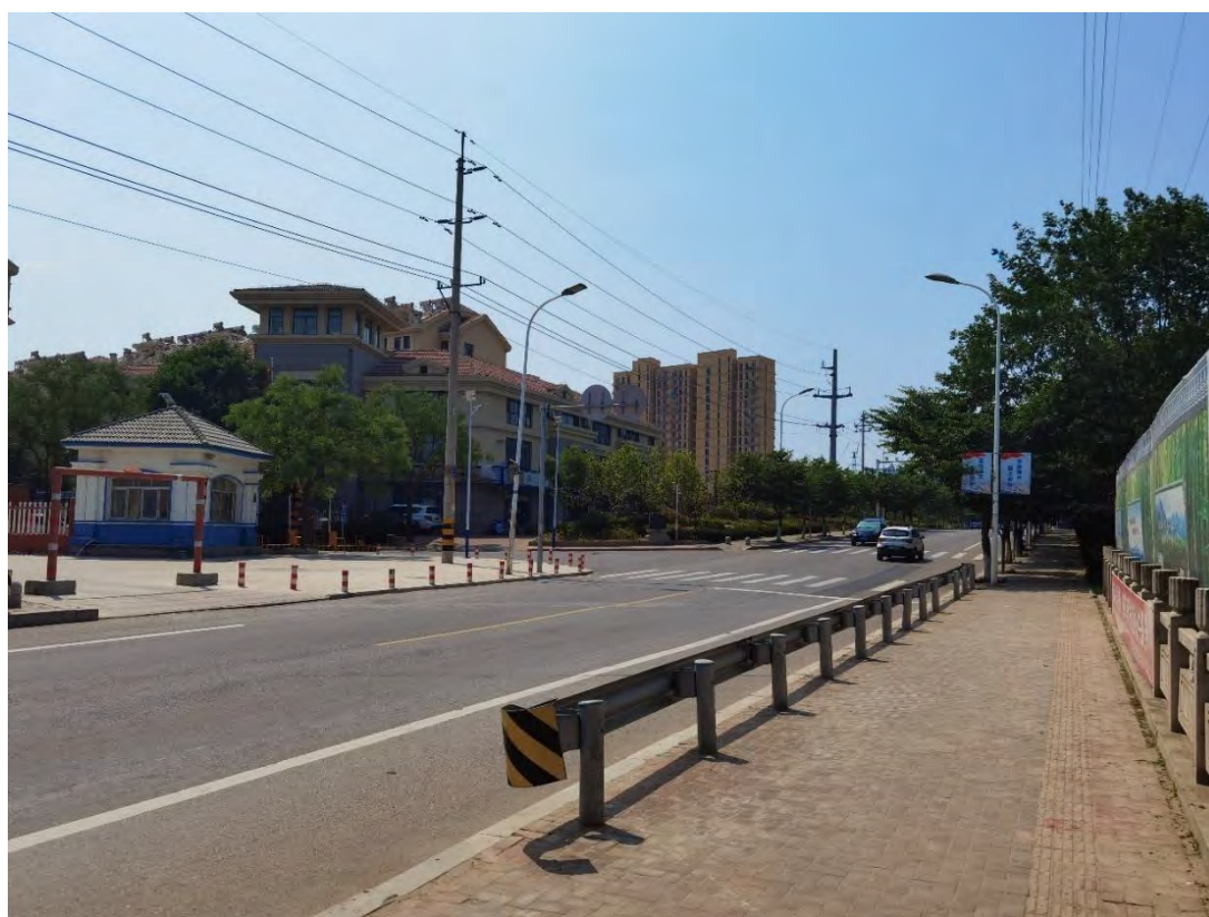
图 3-3 地块外东侧居住用地
