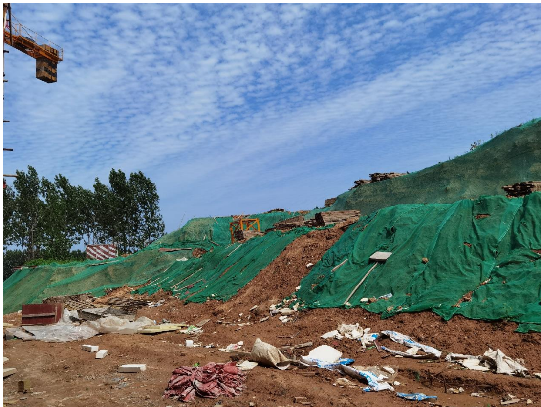
图 3-4 地块外南侧土方堆放
