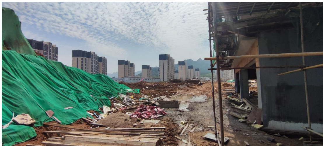
图 3-5 地块外北侧道路及周边楼群
