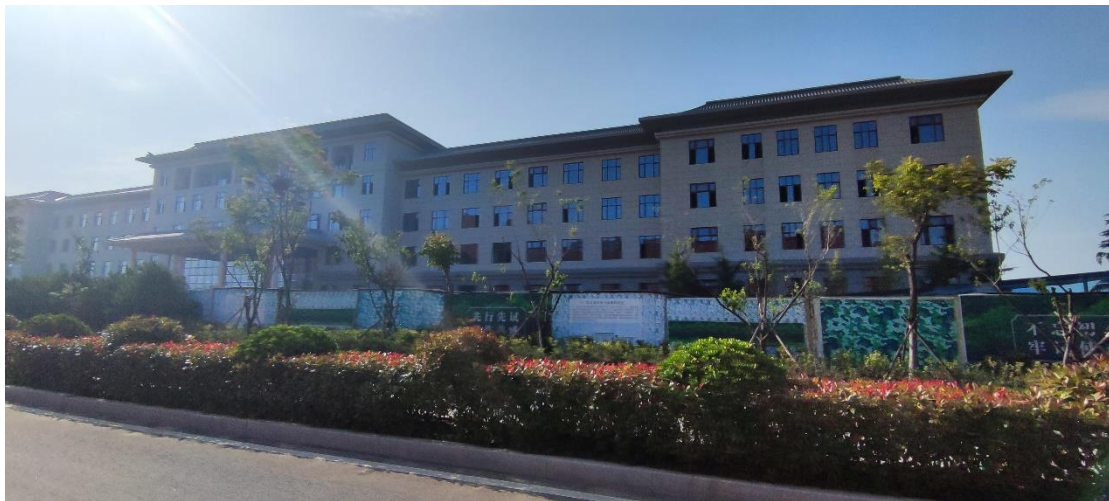
图 3-17 地块外北侧开发建设建筑
