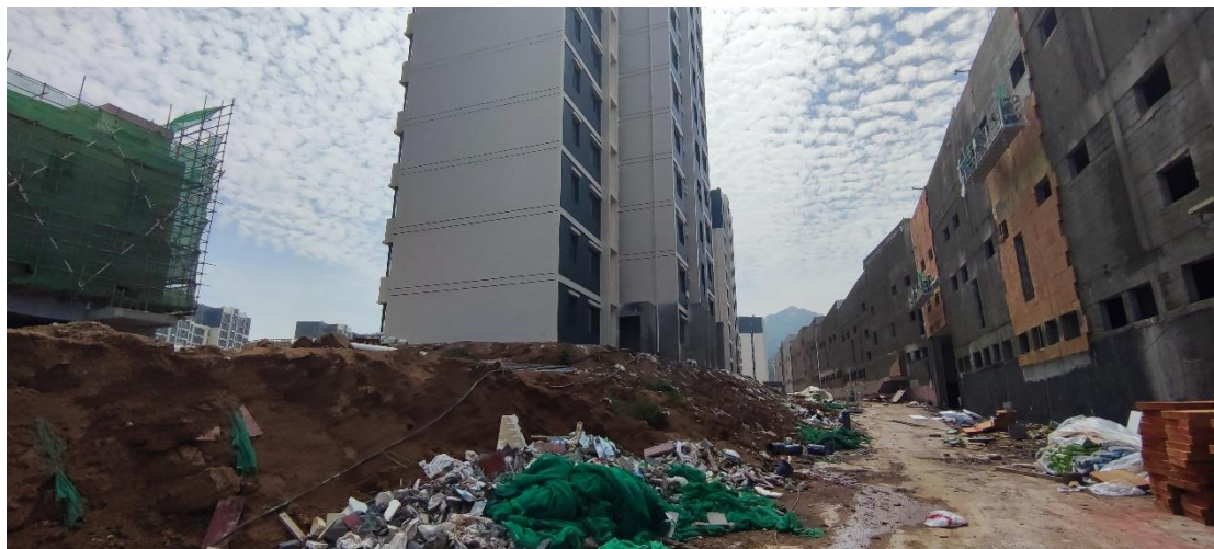
图 3-3 地块外西侧修建好楼房
