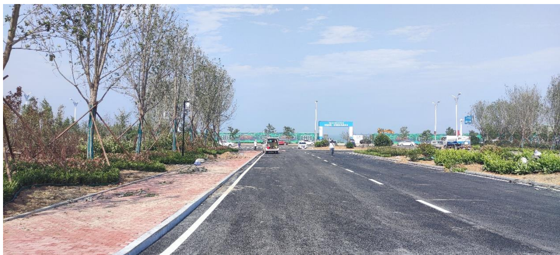
图 3-14 地块外东侧临海道路
