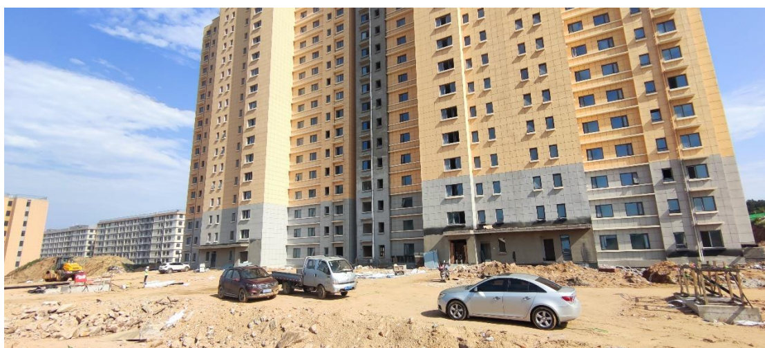
图 3-10 地块外南侧开发建设
