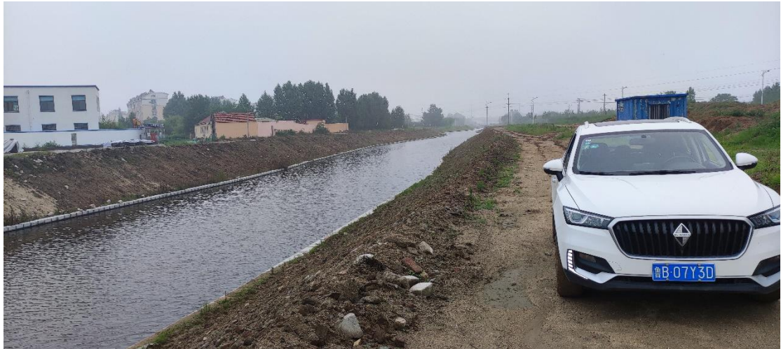
图 3-10 地块外东侧水渠与住宅
