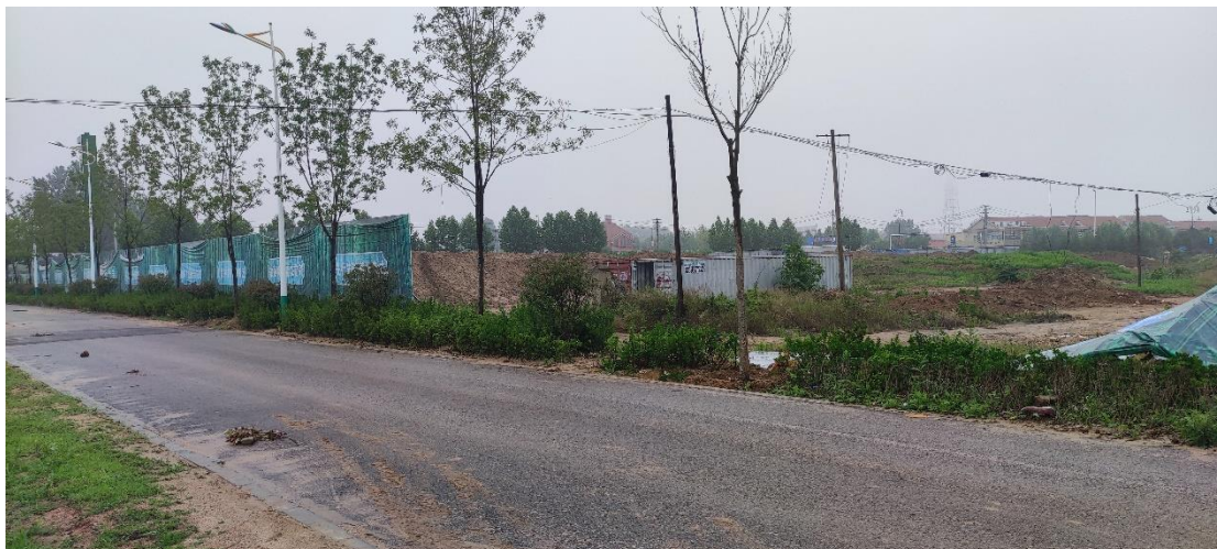
图 3-8 地块内搭设围挡（不完整）、堆放集装箱
