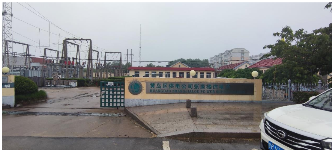
图 3-5 地块外南侧供电所
