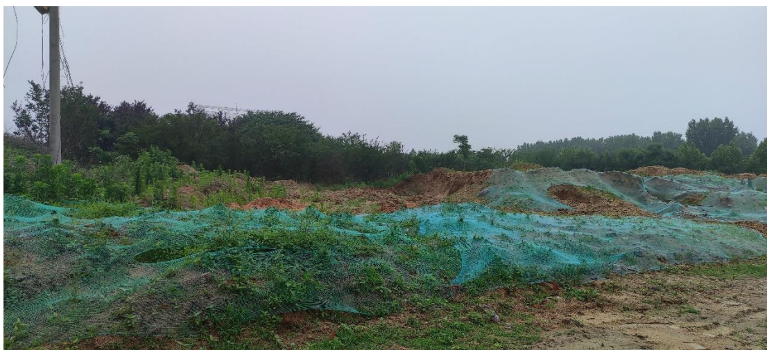
图 3-9 地块内堆土局部进行苫盖
