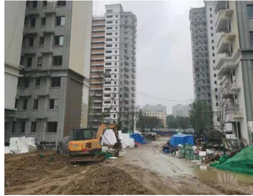
项目内部施工情况
