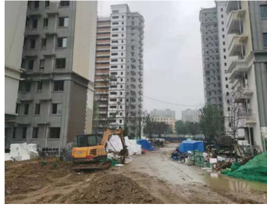
项目内部施工情况
