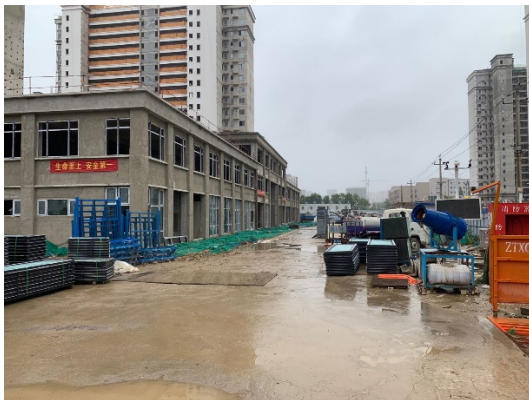
项目内部施工情况
