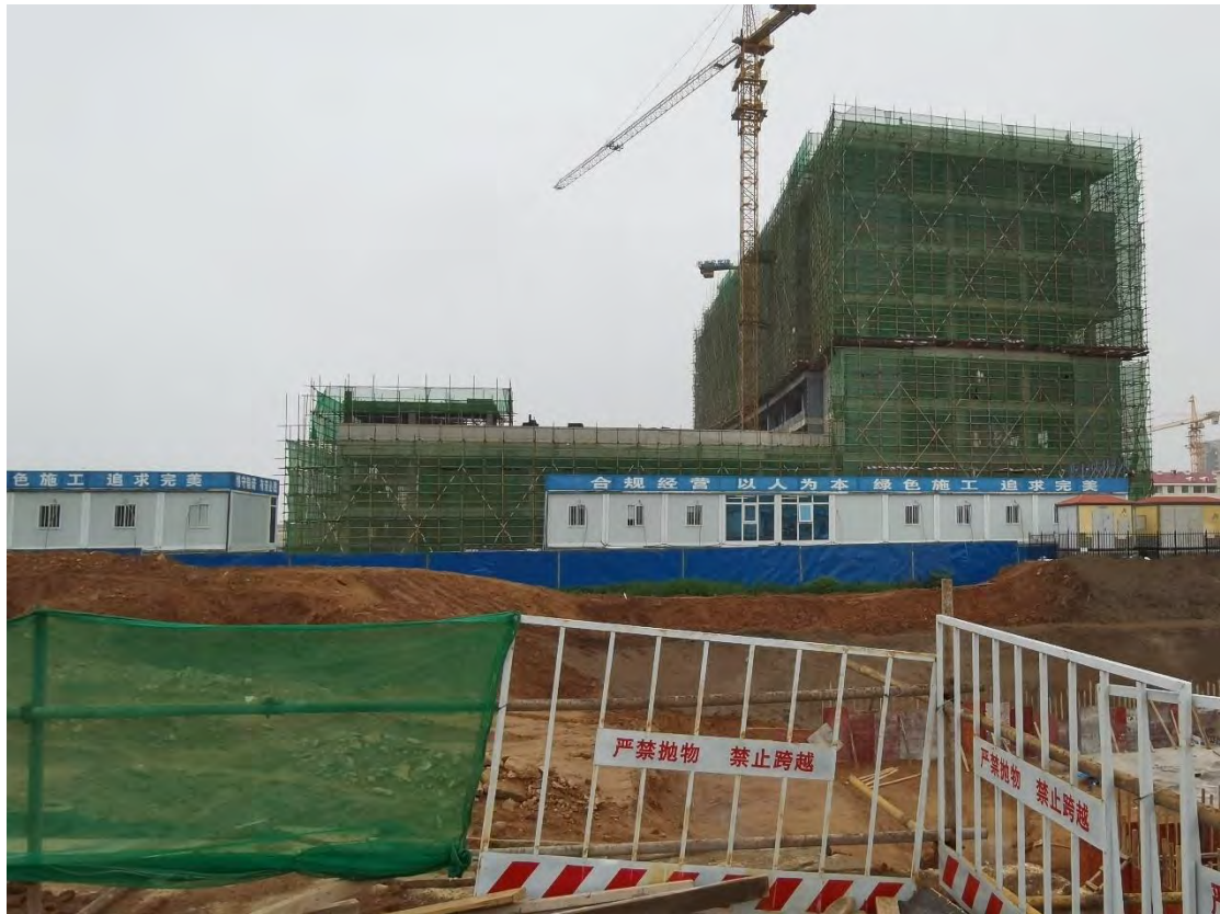
图 3-3 地块内基坑开挖
