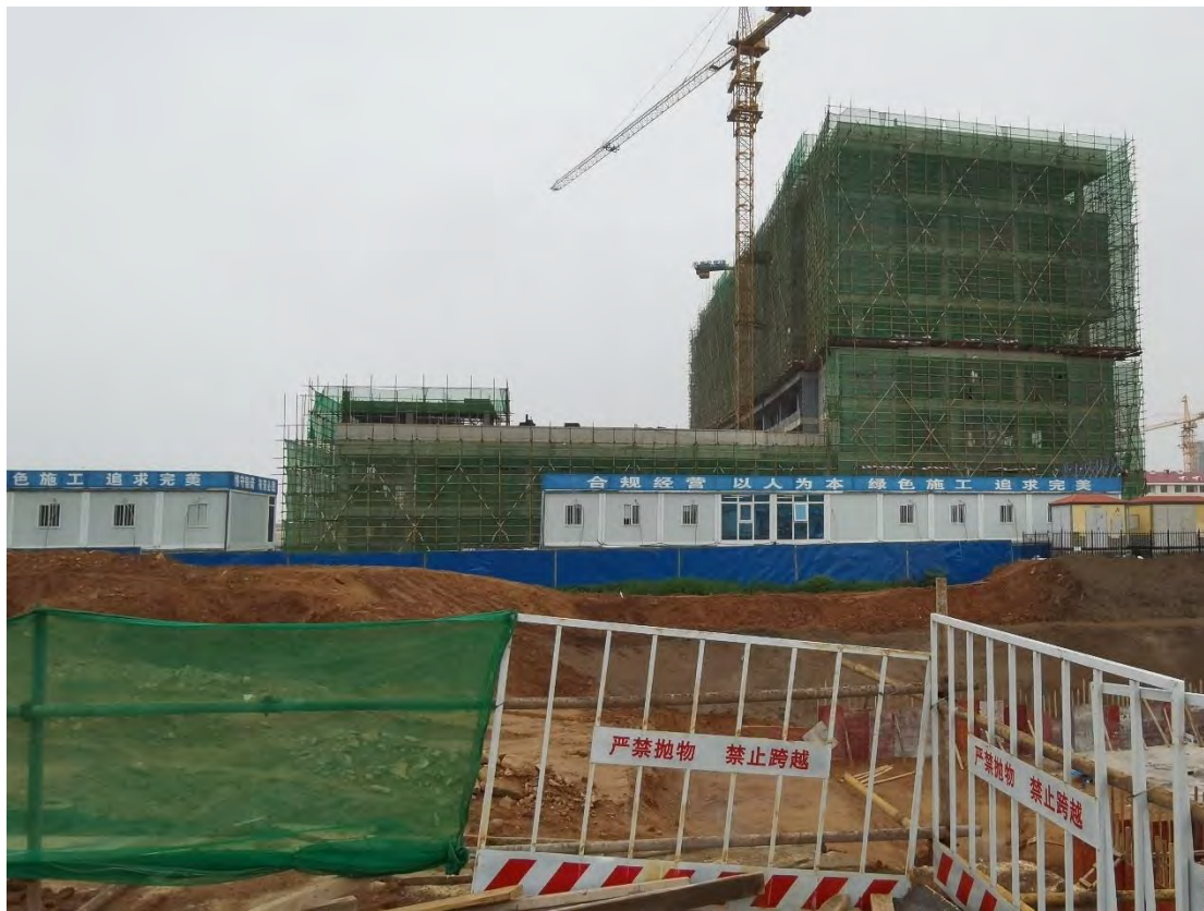
图 3-7 北侧居住用地建设
