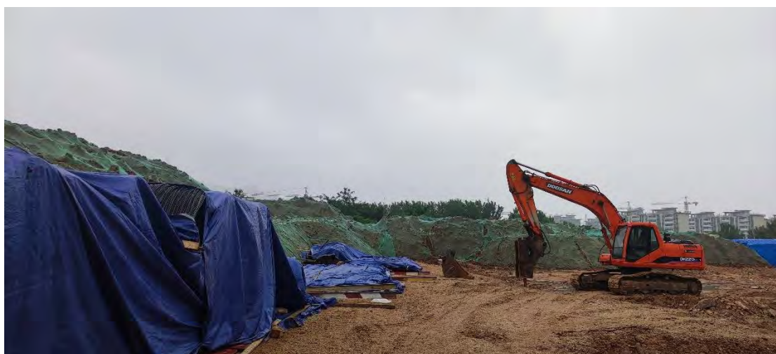
图 3-2 地块内土方堆放与机械设备
