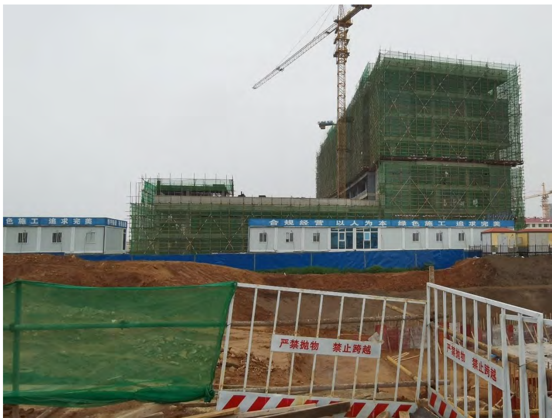
图 2-25 北侧居住用地建设
