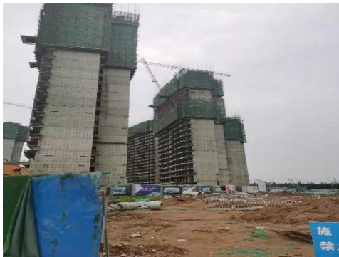
地块南侧空地及在建项目
