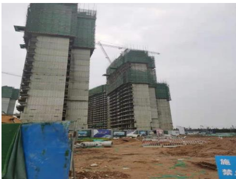
南侧空地及在建项目
