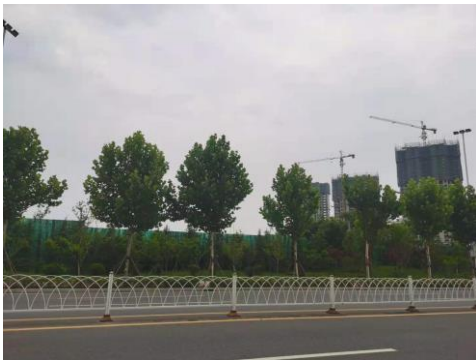
东侧空地及在建项目
