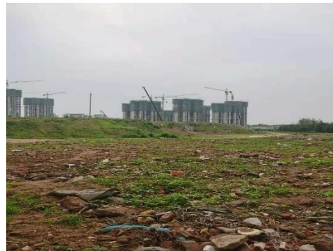
地块北侧空地及在建项目
