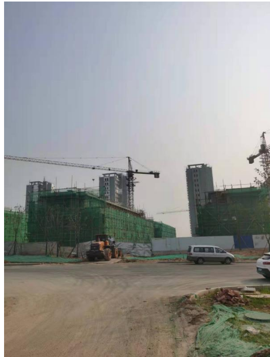
西侧建设中的项目
