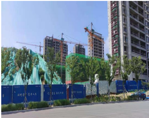
东侧为在建住宅项目
