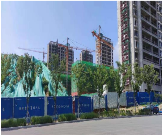
东侧为在建住宅项目
