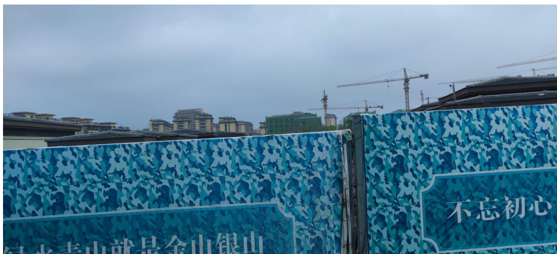
图 3-10 2#地块外西侧建筑工地
