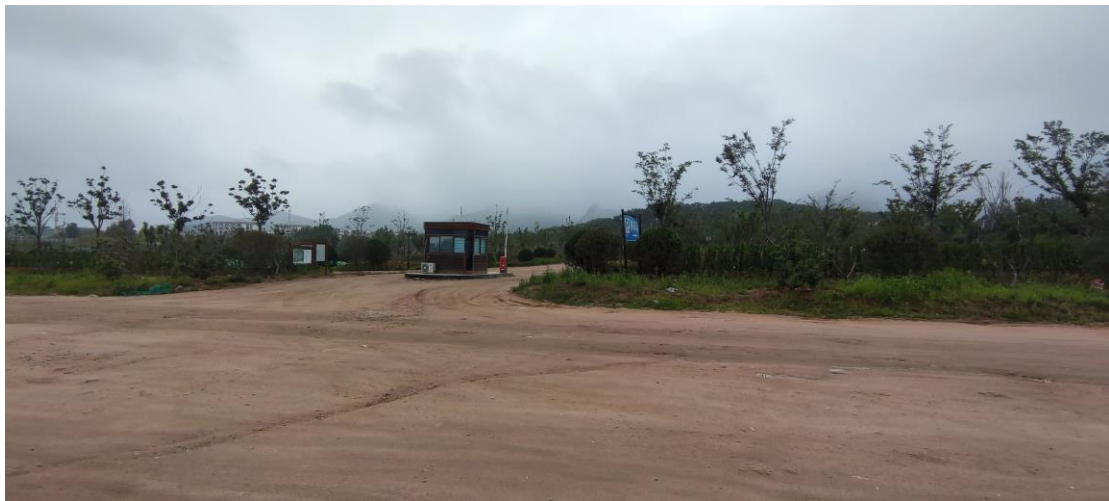
图 3-9 2#地块外南侧停车场
