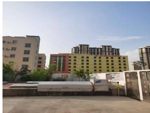
西侧居民住宅、幼儿园
