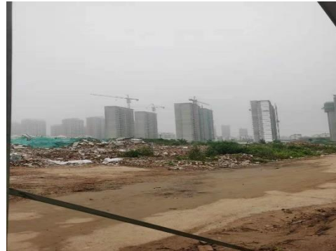
区域西侧在建住宅及空地
