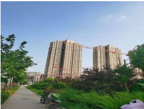
区域南侧居民住宅
