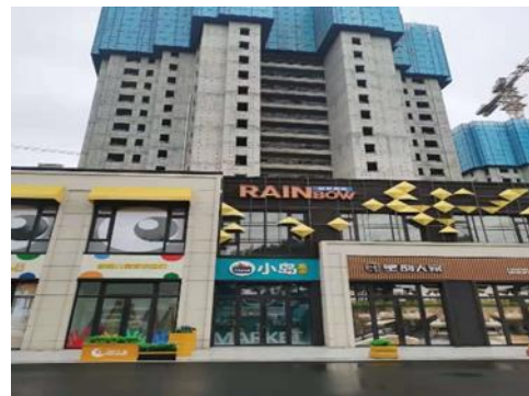
北侧居民用地及在建项目
