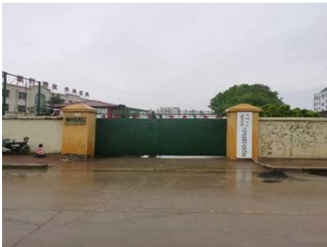
东侧居民用地及公共管理用地
