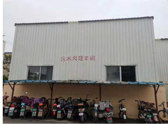
青岛三星污水处理车间
