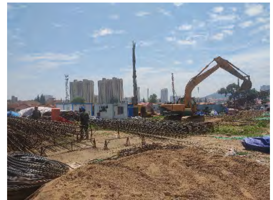
地块内部施工现场
