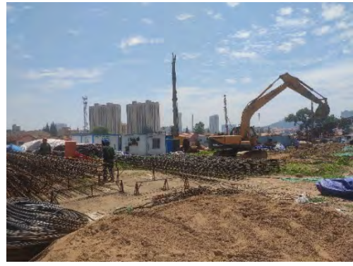
地块内部施工现场
