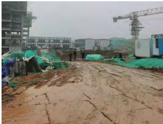
地块内部施工现场
