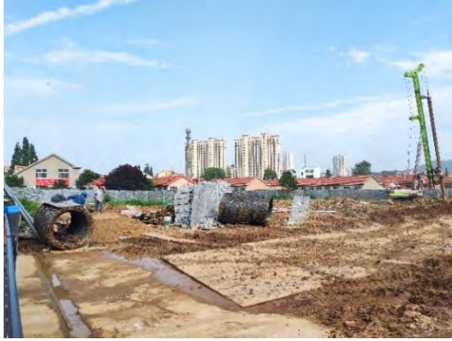
地块内部施工现场
