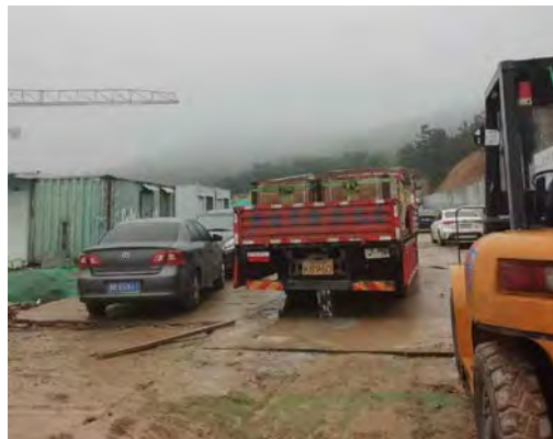
地块内部施工现场
