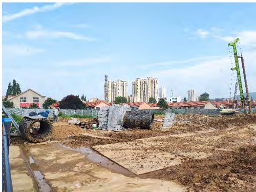
地块内部施工现场
