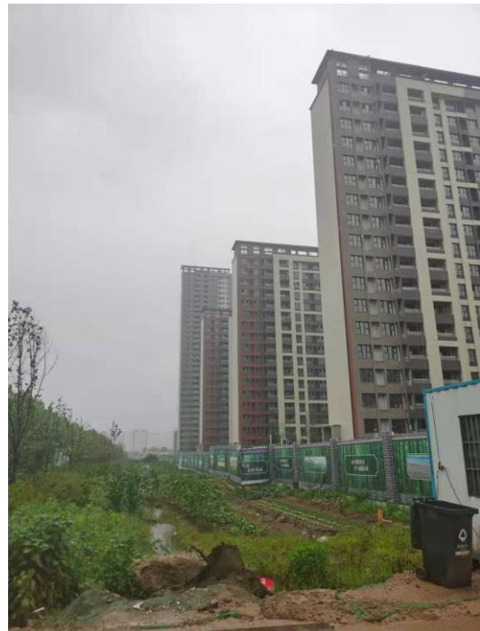
北侧在建住宅
