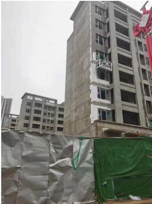
东侧在建住宅
