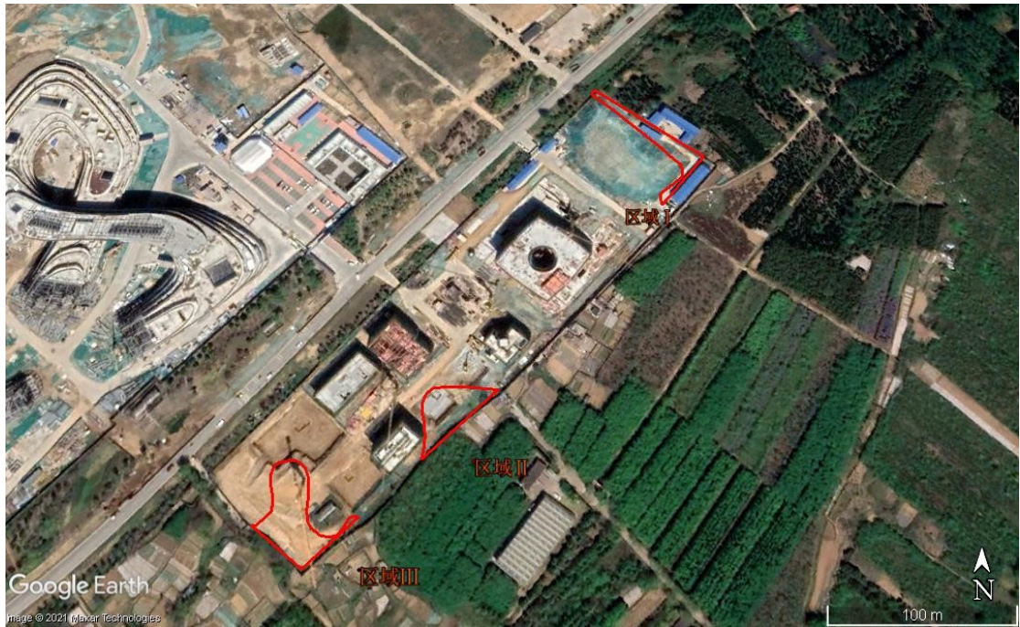
图 2.6 2021 年 5 月 Google Earth 卫星影像图 与 2019 年相比，地块周边工地正进行主体结构施工，区域 II 已进入主体结构施工阶段，区域 III 正进行土石方工程
