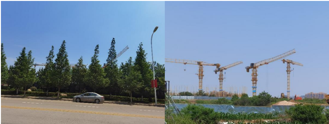
图 3-4 调查地块西侧道路及对面工地
