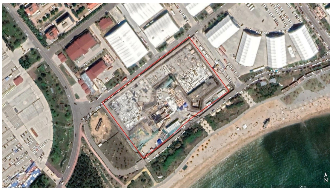
图 2.9 地块 2021 年 6 月卫星影像图 与 2020 年相比，地块上原有建筑物已拆除，并正在进行主体结构施工
