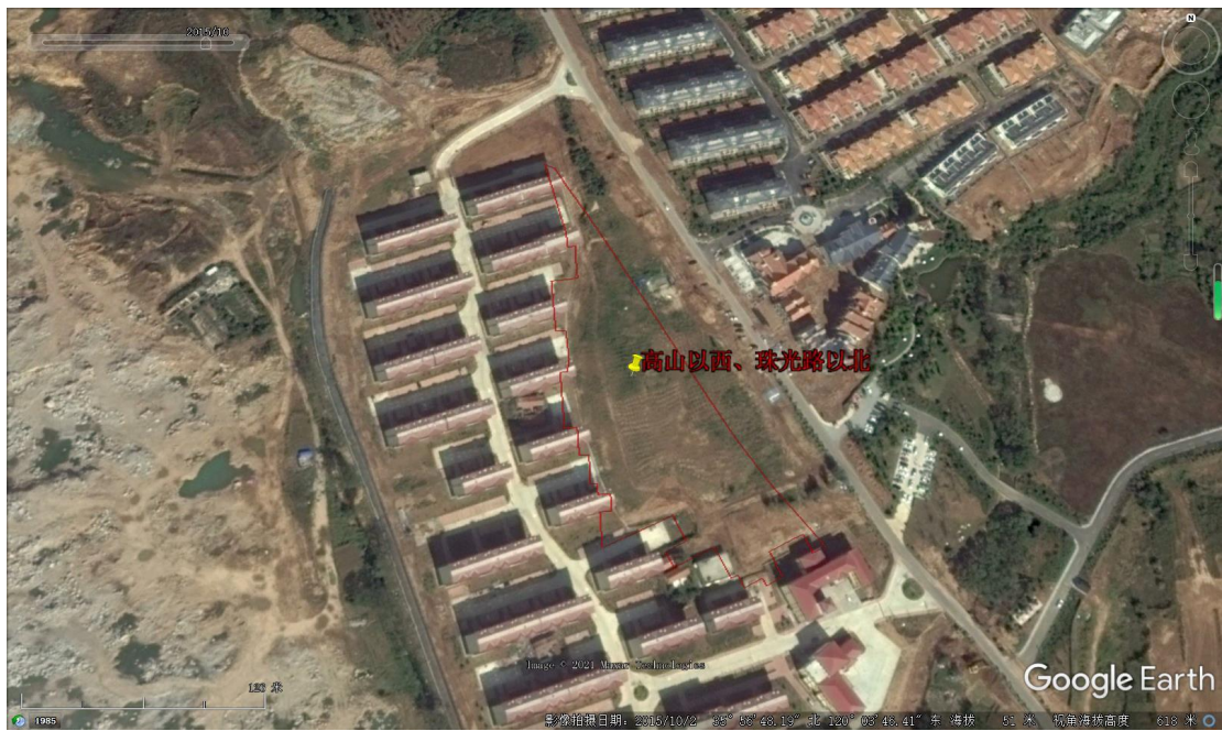
图 2-15 2015 年（与 2013 年相比，变化较大，西侧面上村安置房项目完工，东侧房地产项目也以完工）
