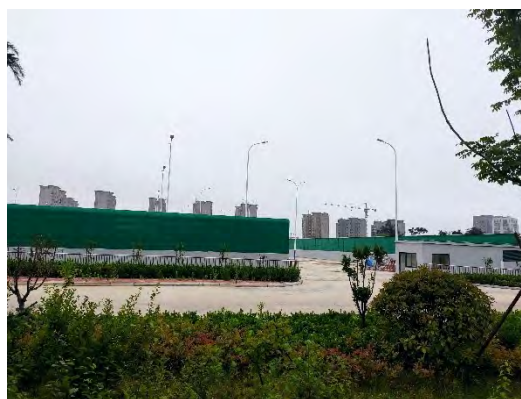
地块西侧公交场站
