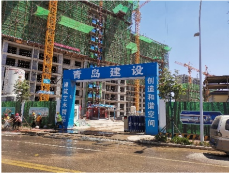
东侧其他在建工地
