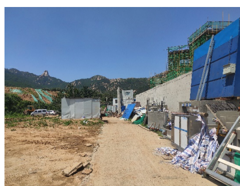
西侧其他在建住宅楼
