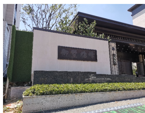
北侧已建好住宅楼
