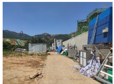
西侧其他在建住宅楼
