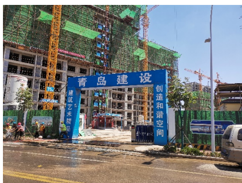
东侧其他在建工地
