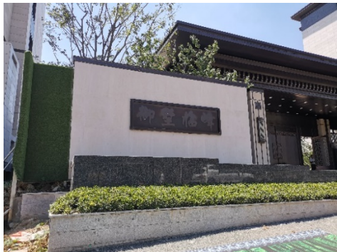
北侧御墅临峰小区
