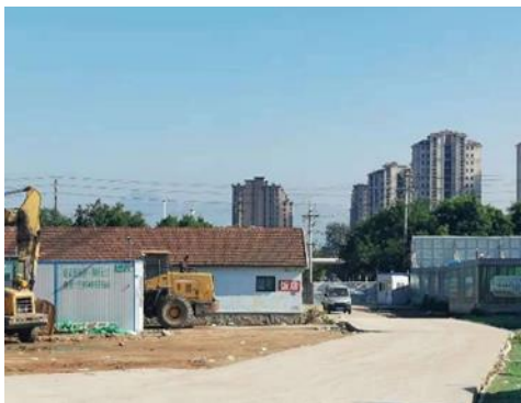
南侧居民住宅
