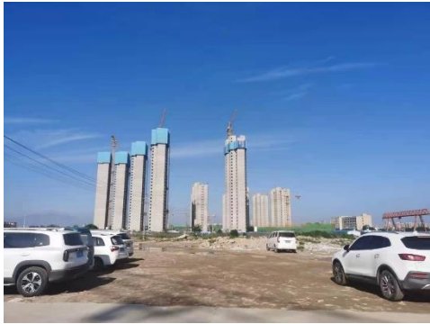
地块东侧空地及在建居民住宅
