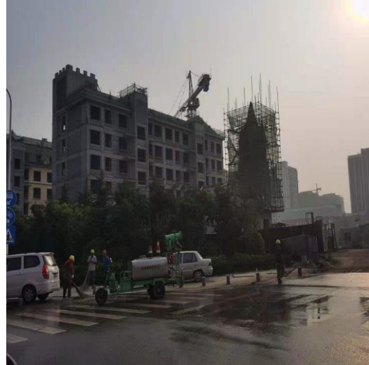
西侧住宅项目
