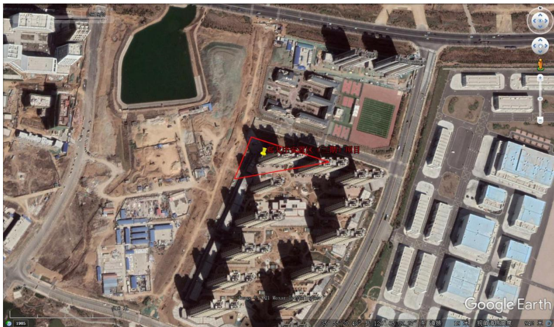
图 2-13 2019 年（与 2016 年相比，区域北侧学校已建设完工，南侧安置区项目也已完工，西侧区域的随着周边建设工程的结束，临时板房正在拆除，东侧建设了影视基地）
