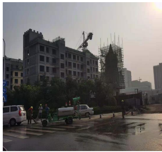
西侧在建住宅项目
