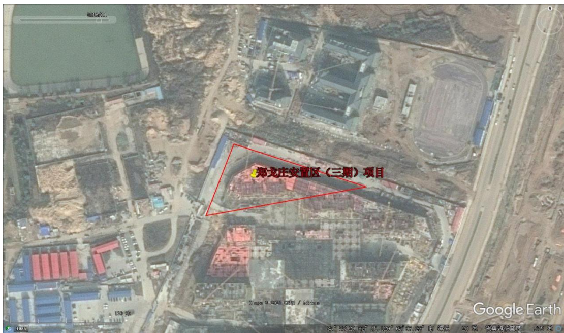
图 2-5 2016 年（与 2015 年相比，项目区域内变化较大，项目已开工并在进行基坑挖掘）
